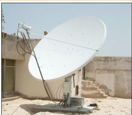
Station VSAT pour le réseau de télécommunication en Mauritanie
